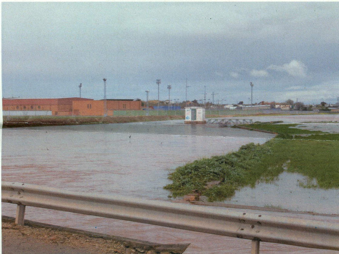
Inundación de 05/04/2013. Estación de Aforo 4102. Azuer en Daimiel.
