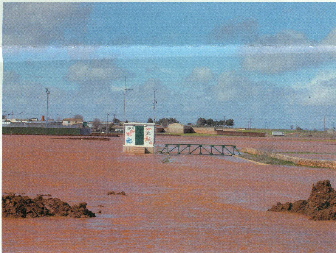
Inundación de 23/02/2010. Estación de Aforo 4102. Azuer en Daimiel.
